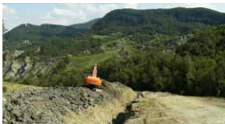
Esecuzione di drenaggio
