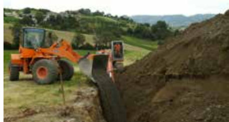
Esecuzione di drenaggio
