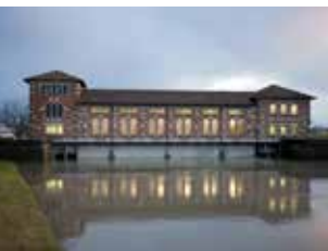
Impianto Idrovoro Bondeno-Palata
