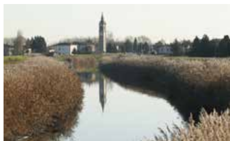
Canale Collettore di Burana
