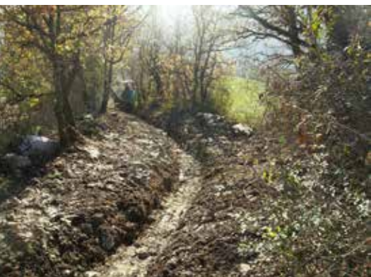
Esecuzione di affossatura
