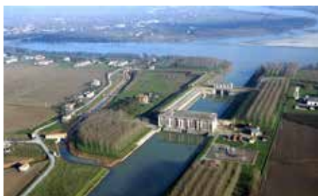
Impianto Idrovoiro Pilastresi
