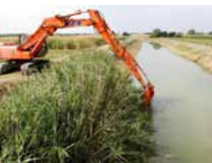
Pulizia di un canale
