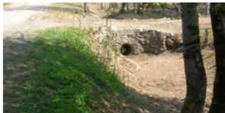
Pulizia del tombino sottopassante la viabilità
