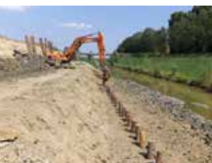
Palificazione per sistemazione frana
