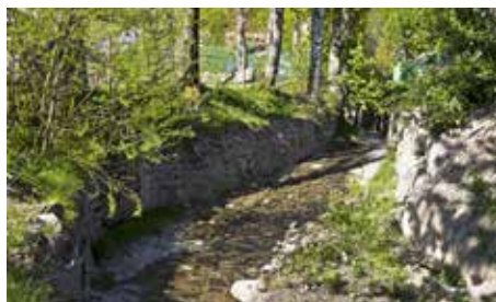
Sistemazione spondale in pietrame
