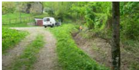
Manutenzione di un fosso vicino alla viabilità
