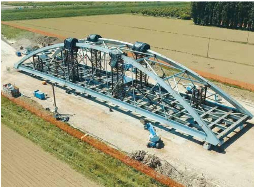
in cantiere che ha dato esito soddisfacente. Il varo del nuovo ponte, che sarà **a campata unica di 80 metri e due archi di altezza di 12 metri circa con una carreggiata larga 14 metri a due corsie e con due piste ciclabili laterali**, è previsto nel periodo di massima siccità del Panaro che si prevede possa essere compreso fra la metà di luglio e di agosto.
